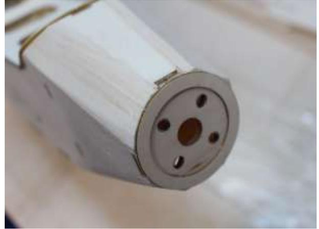
Rundspant (J) genau mittig am Kopfspant (D2) verleimen.
